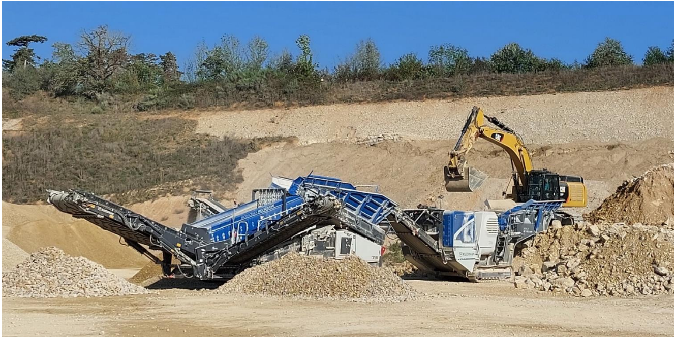
Installation de traitement mobile en cours de traitement des matériaux issus de la carrière de Cotte-Ferré, localisation : Site de Palenge, Octobre 2023
