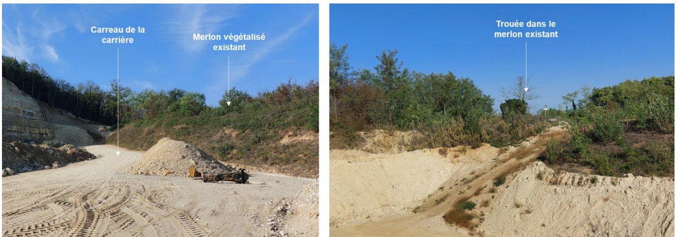
À gauche : Carreau de la carrière et merlon végétalisé existant / À droite : Trouée dans le merlon existant, qui a été comblée afin d'assurer une continuité en limite de propriété
